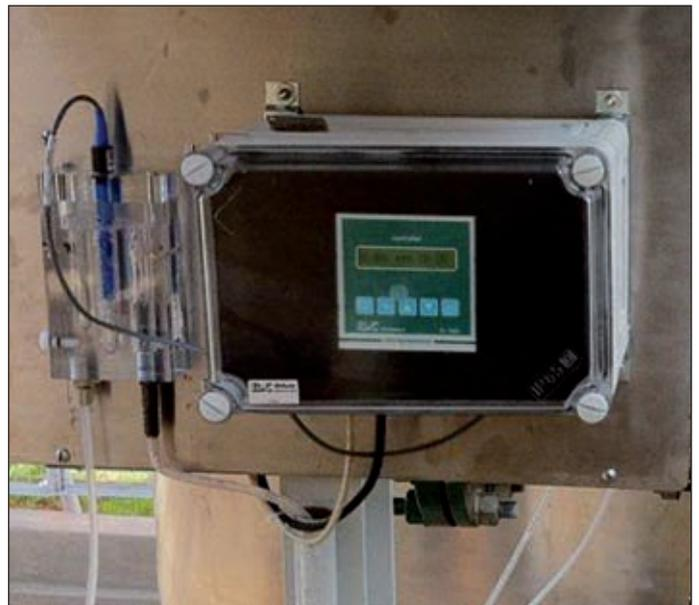
Tipica installazione del sensore con controller CL 7685 e cella a deflusso SZ 7231.
